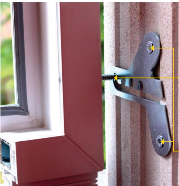
Fensterbauschraube FBS-Z 7,5x152 oder Fensterbauschraube FBS-Z 7,5x212
